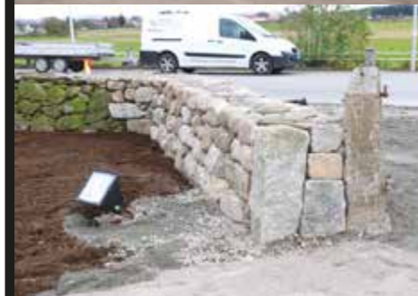
Den gamle steinmuren hadde to innganger, den ene åpningen er nå steinlagt mens den andre inngangen har blitt flyttet noen meter inn. Nå blir det lettere for bærebil å ankomme kirken. Legg merke til de gamle flotte gjenbrukte steinblokkene til porten.
